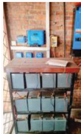
Batteries d'accumulateur Panneaux Solaires
